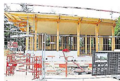
Les travaux ont commencé, sur le parvis des Machines.
